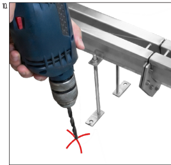
Bohrlöcher für Bodenverankerung erstellen und Rinnenlinie an die Rohbetondecke befestigen
