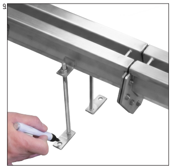
Rinne ausrichten/positionieren. Bohrlöcher für Bodenverankerung markieren
